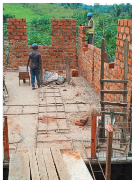
Ochranné zábradlí po celém obvodu druhého patra ...Budování cihlových stěn
