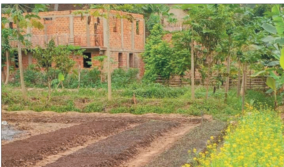
Zdi druhého patra jsou hotové a připravené nést střechu
