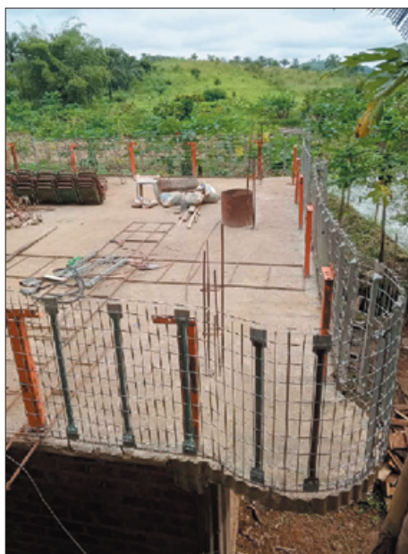
Ochranné zábradlí po celém obvodu druhého patra ...Budování cihlových stěn
