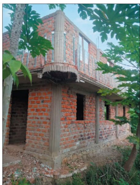
Ochranné zábradlí po celém obvodu druhého patra ...Budování cihlových stěn
