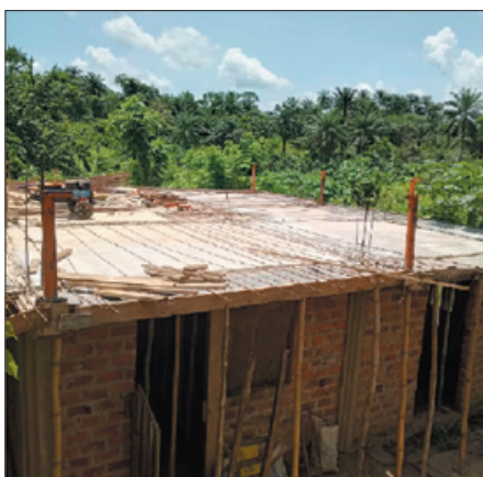
Nejnáročnější a nejnákladnější část projektu - pokládání podlahy pro druhé patro
