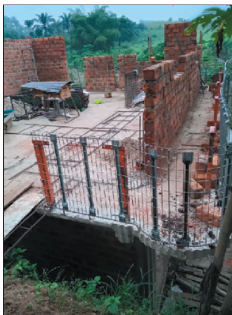
Ochranné zábradlí po celém obvodu druhého patra ...Budování cihlových stěn
