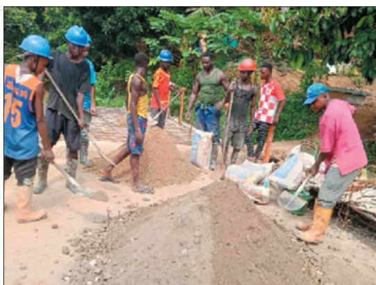
Stážisté stojí na patře a míchají beton ... Vpravo - podlaha je hotová!
