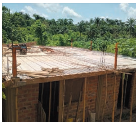
Der schwierigste & teuerste Teil des Projekts – das Gießen der Bodenplatte für das 2. Stockwerk
