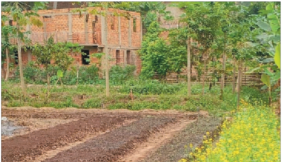
Die Wände des 2. Stockwerks sind fertig und bereit für das Dach
