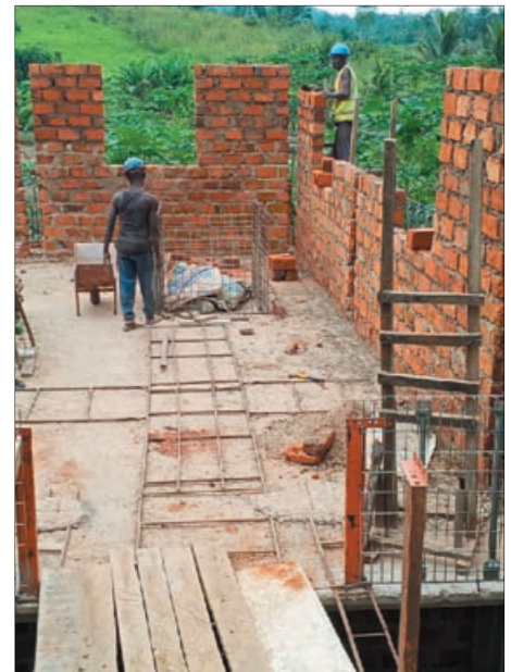
Schutzgeländer rund um das zweite Stockwerk ... Die Wände werden hochgezogen
