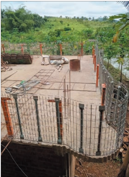
Schutzgeländer rund um das zweite Stockwerk ... Die Wände werden hochgezogen
