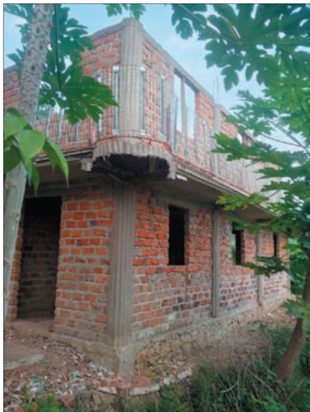
Schutzgeländer rund um das zweite Stockwerk ... Die Wände werden hochgezogen
