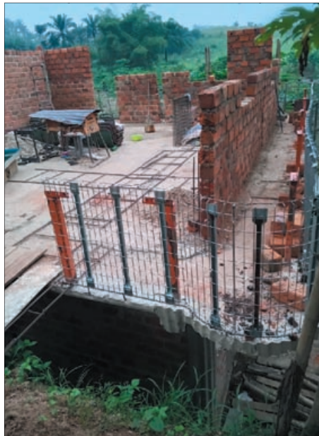
Schutzgeländer rund um das zweite Stockwerk ... Die Wände werden hochgezogen
