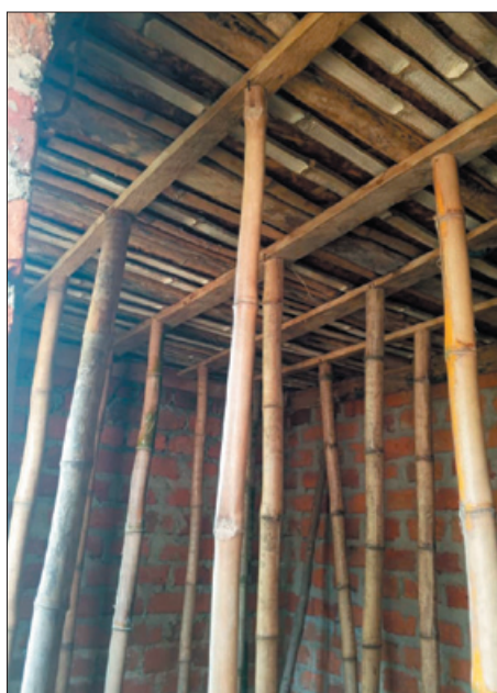
Josef nasekal bambus, aby podepřel konstrukci, která udrží podlahu ze spodu na místě, dokud beton nevyschne.
