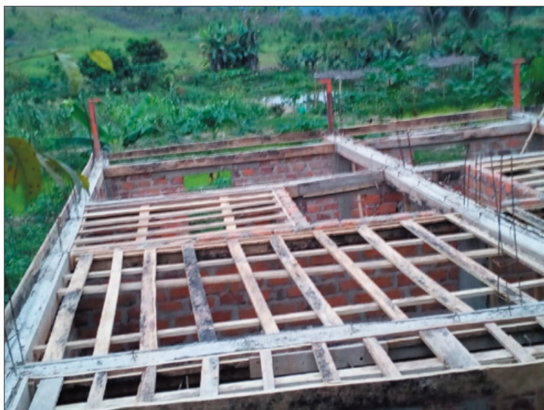
Nahoře - Dřevěná konstrukce pro 2. patro
