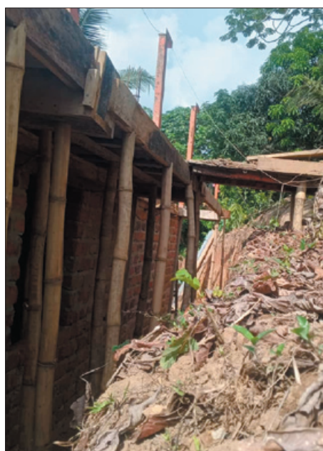
Josef nasekal bambus, aby podepřel konstrukci, která udrží podlahu ze spodu na místě, dokud beton nevyschne.
