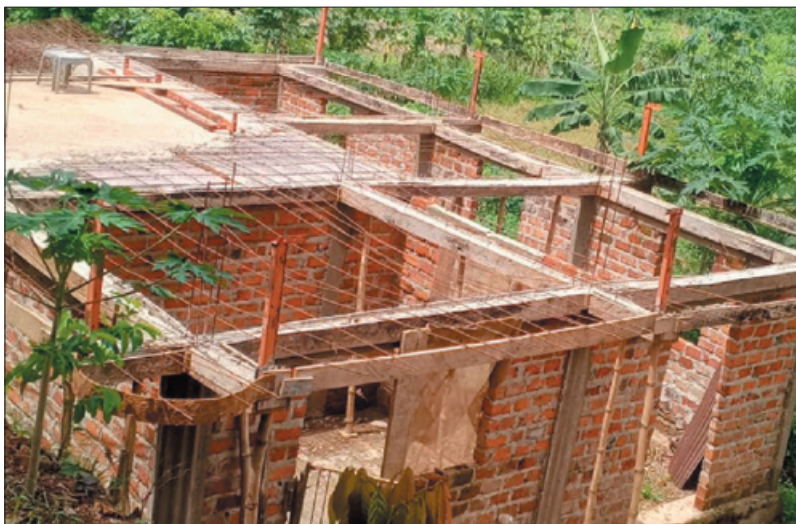
Část podlahy pro druhé patro byla položena
