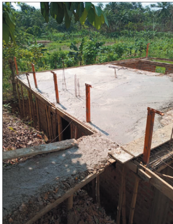
Nejnovější vývoj na výstavbě školní budovy
