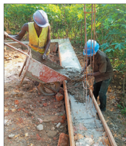
Kopání, měření, přidávání sloupů, kamenů a betonu
