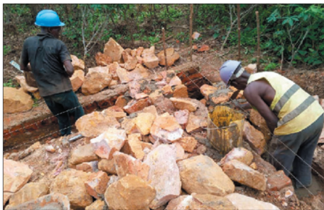
Kopání, měření, přidávání sloupů, kamenů a betonu
