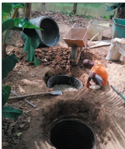
Stavba rybí líhně
