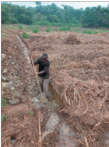
Kopání příkopů proti záplavám
