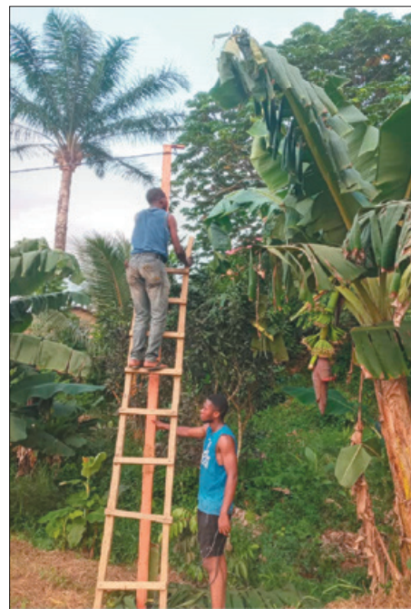
Upevňování kabelu na sloupy...
