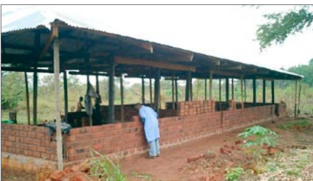
Gauche: D'abord on termine le toit étanche et après on construit les murs.
