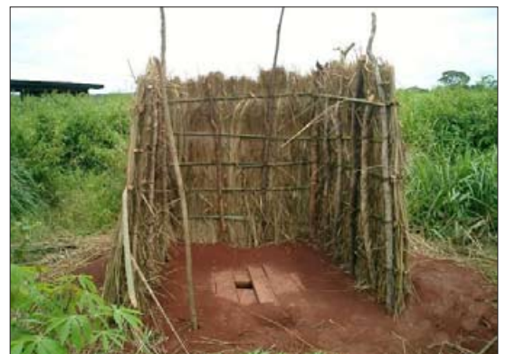
Cabinets rudimentaires sur le site de l'école
