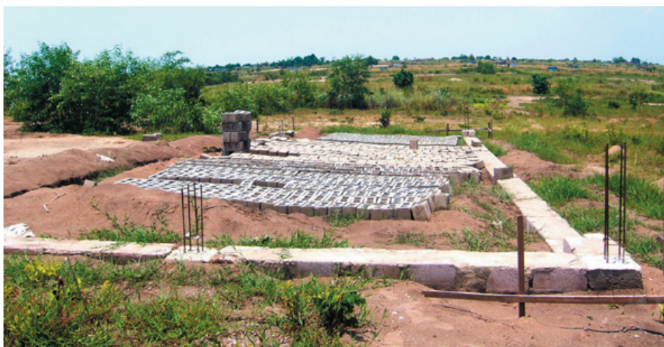
La fondation de l'école est en train d'être posée et des briques sont fabriquées pour la construction
