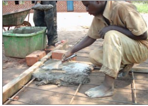
Wasserreservoir im Bau (l), Zementdecke geformt (r) und fertig (unten)
