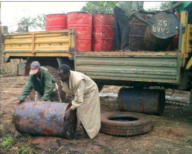
Zwanzig 200 Liter Wassertonnen auf der Baustelle.
