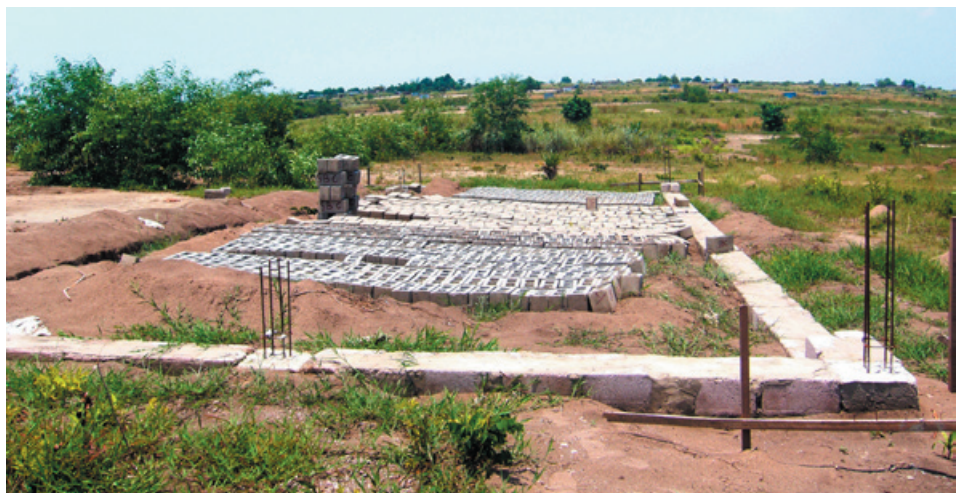
Das Fundament für die Schule wird gelegt & Bausteine für den Aufbau gefertigt
