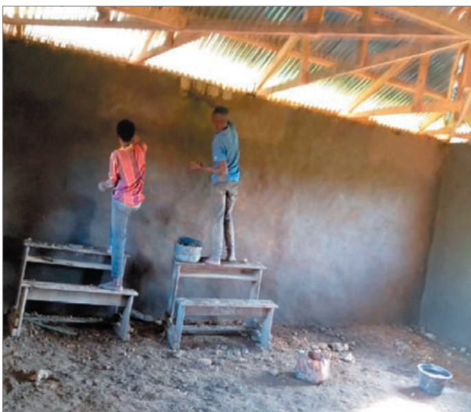
Fertigstellung der Klassenräume von innen: Verputzen der Wände und Zementieren der Böden
