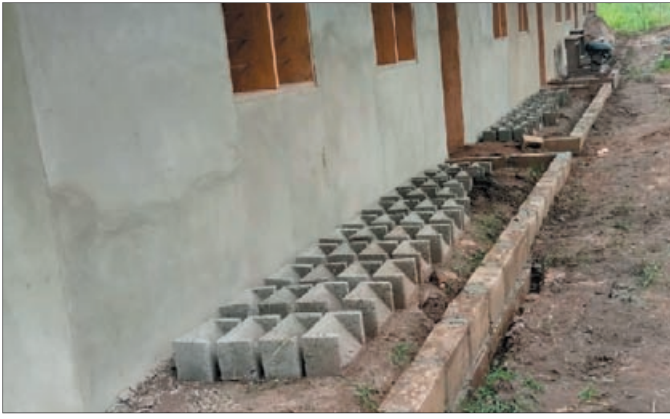
Steine zum Schutz der Fenster und zur Belüftung
