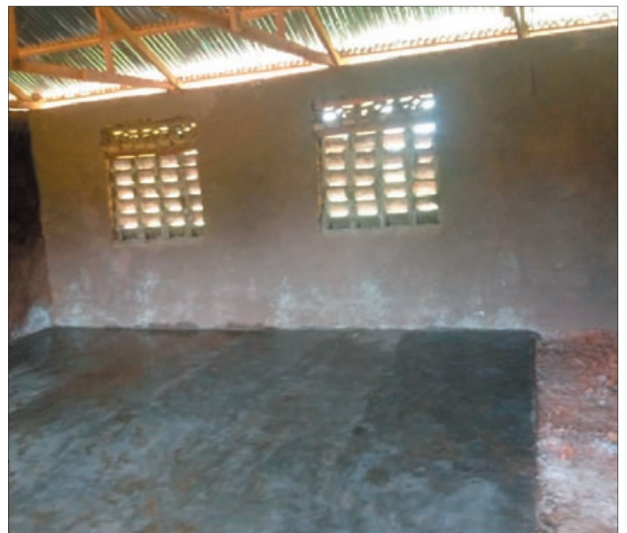
Fertigstellung der Klassenräume von innen: Verputzen der Wände und Zementieren der Böden
