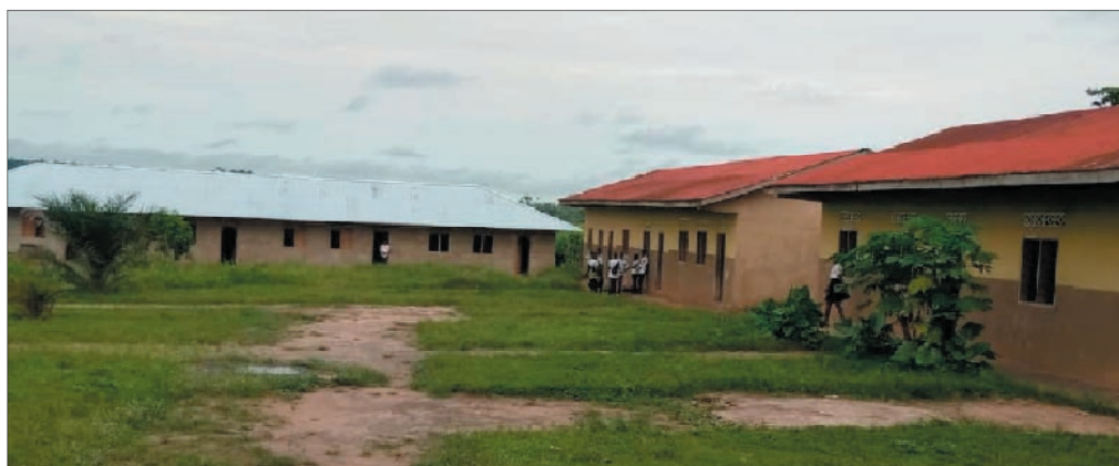
Bau eines neuen Schulgebäudes mit vier Klassenzimmern (links)
