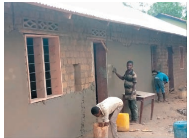
Verputzen der Wände zum Schutz vor Regen
