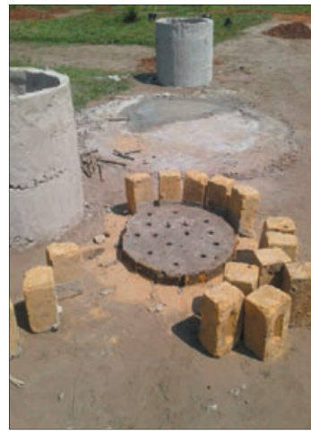
1. Das Brunnenloch wird gegraben 2. Vorbereiten von Zementringen 3. Wasserfilter 4. Einsetzen der Zementwände
