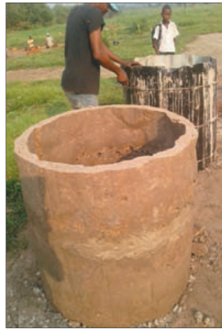
1. Das Brunnenloch wird gegraben 2. Vorbereiten von Zementringen 3. Wasserfilter 4. Einsetzen der Zementwände
