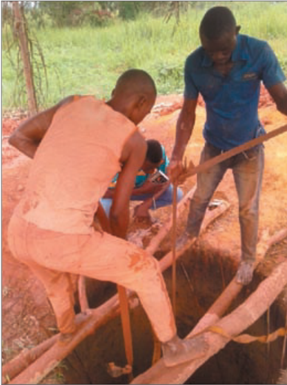
Arbeiten am Brunnen in vollem Gange!
