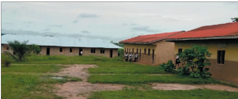
Stavba nové školní budovy (vlevo vzadu)
