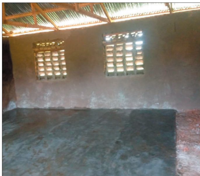
Dokončování vnitřních prostor učeben: omítání stěn a tmelení podlah
