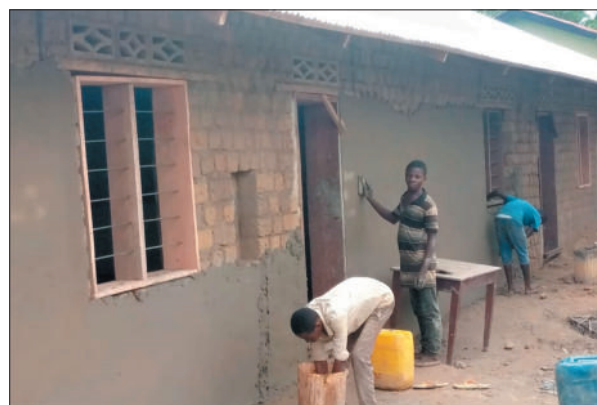
Omítání stěn kvůli ochraně před deštěm
