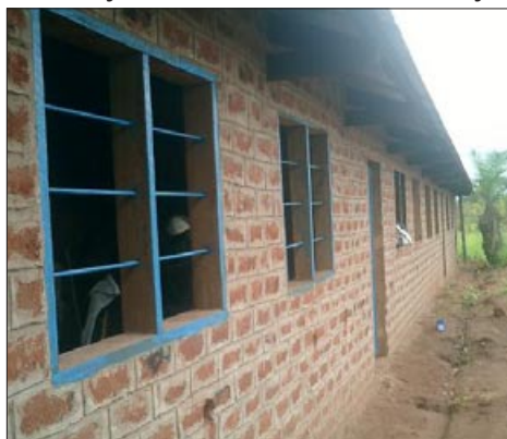
Dokončená druhá budova
