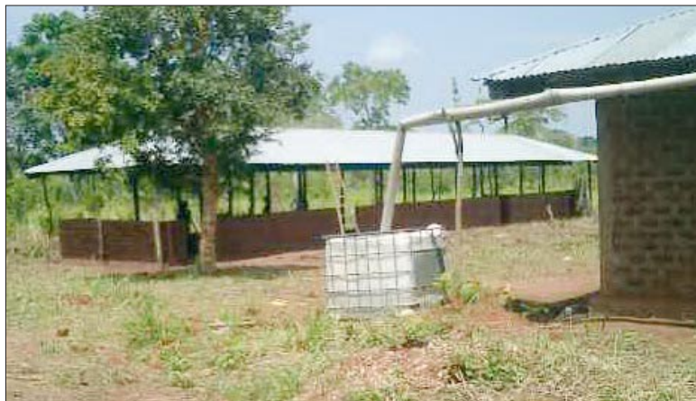
Během chvíle položili střechu a postavili půlku zdi
