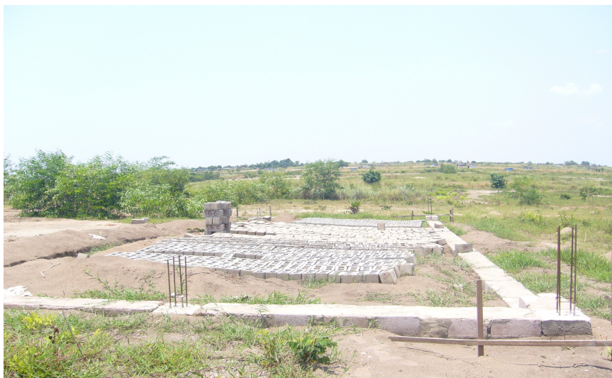
Vybudované základy pro školu
