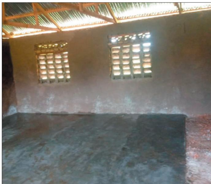
*Finition de l'intérieur des salles de classe. Crépir les murs et cimenter les sols.*
